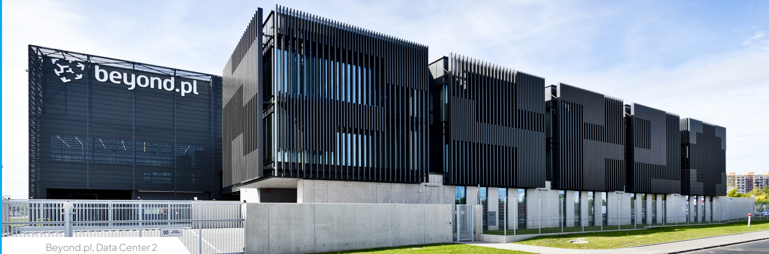
Beyond.pl, Data Center 2
